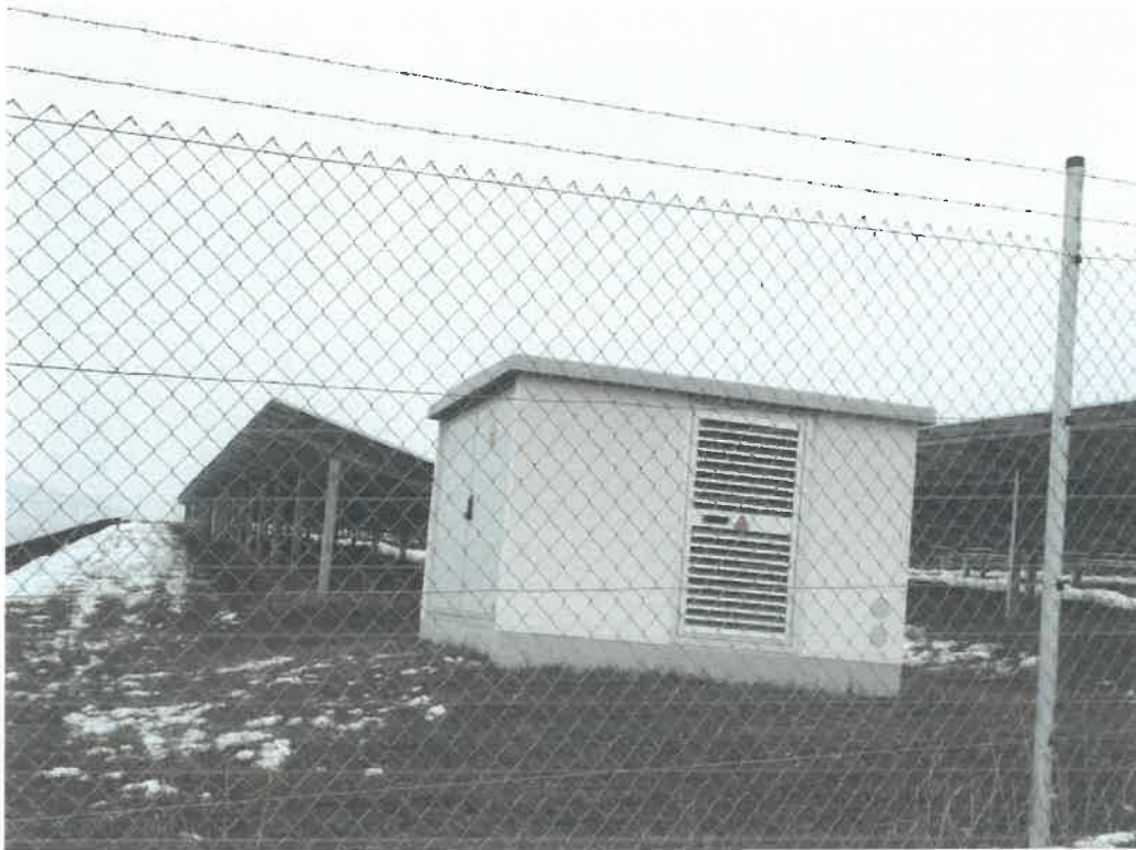
Trafostation einer gleichartigen Photovoltaik-Freiflächenanlage. Je 1 ha Anlage ist mit einer Trafostations zu rechnen. Der Trafo ist deutlich niedriger und schmaler als die Modultische .
