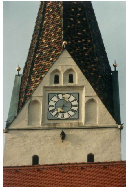
(Foto Betläuter am Andreasturm)
