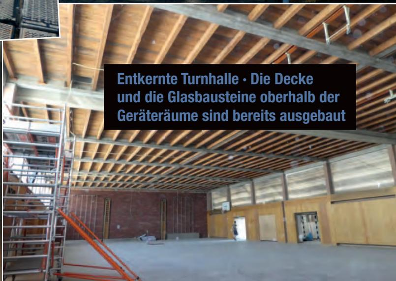
Entkernte Turnhalle - Die Decke und die Glasbausteine oberhalb der Geräteräume sind bereits ausgebaut
