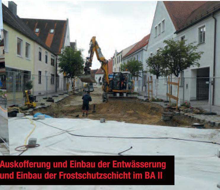
**Auskoffung und Einbau der Entwässerung und Einbau der Frostschuttschicht im BA II**
