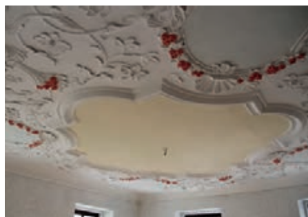
Decke im Südwestzimmer des Obergeschosses, Stand 2018
