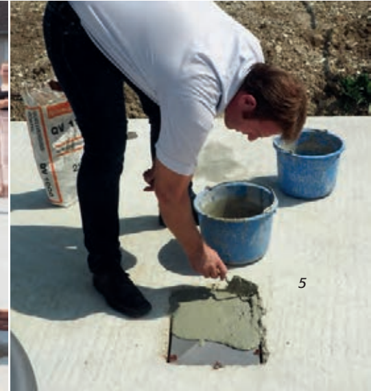
Die Kasette wird verlötet und verschwindet unter einer Betonschicht.(4, 5 + 6) Foto: Bauer
