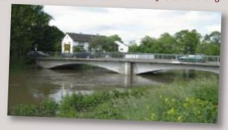
Auch dieses Foto wird bald schon Geschichte sein: denn die neue filigrane Brücke wird keinen Mittelpfeiler mehr haben und dient damit der Verbesserung des Hochwasserschutzes, weshalb die Maßnahme auch vom Freistaat entsprechend gefördert wird.
