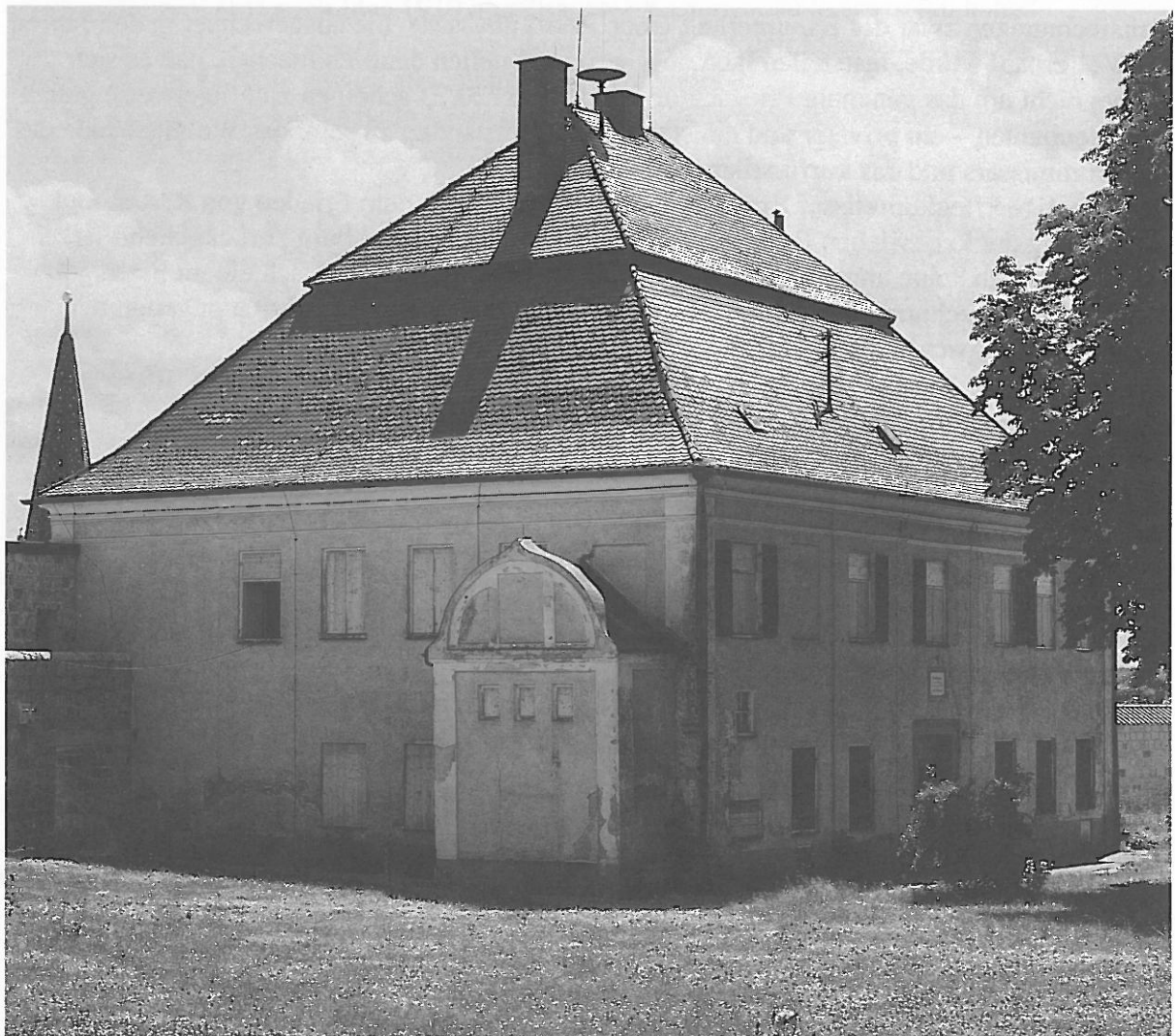
Foto: Leander Hopf, Bergheim (Gesamtansicht über NW-Ecke, Blick nach SO, Aufnahme am 20. 06. 1999)
